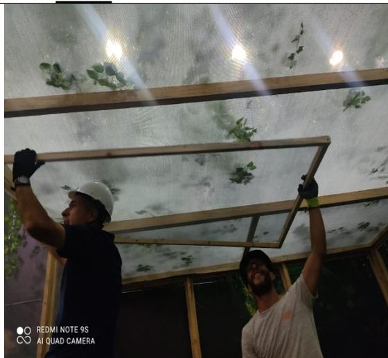
Foto 6. Cielo raso con doble malla para evitar fuga de los individuos
